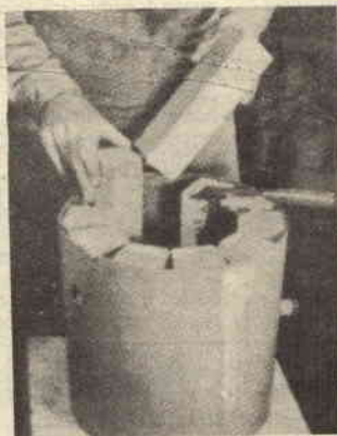
2 - Come disporre nell'interno i mattoni refrattari
